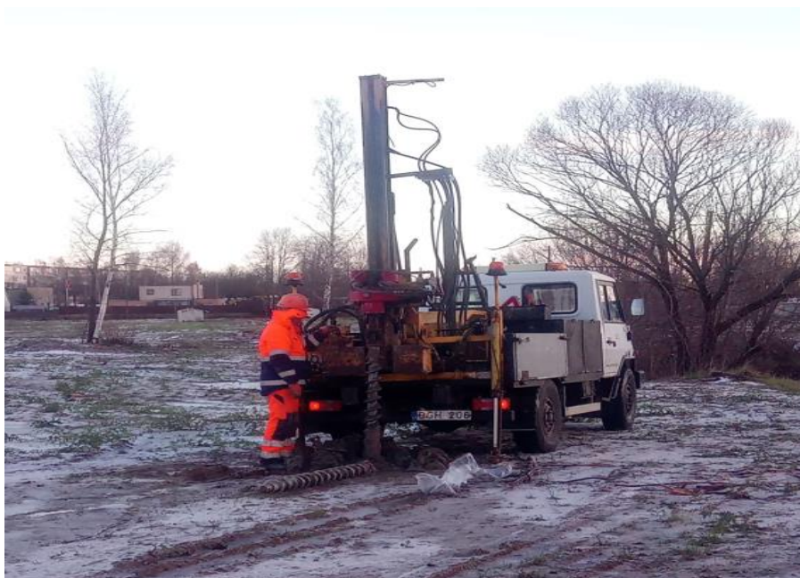
1 pav. Lauko darbai
